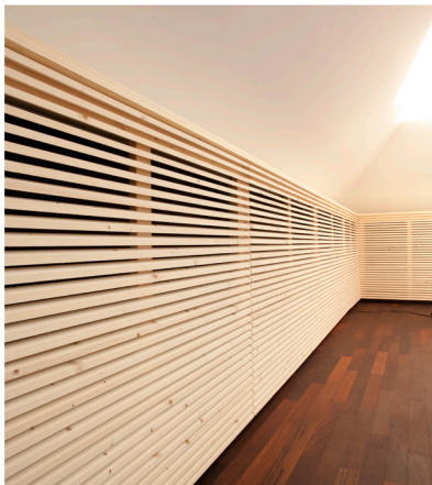
Quelluftauslass mit Holzverkleidung.
