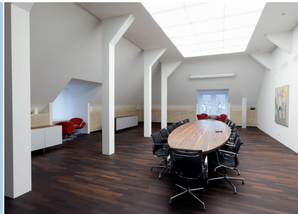
Quelluftauslass mit Holzverkleidung.
