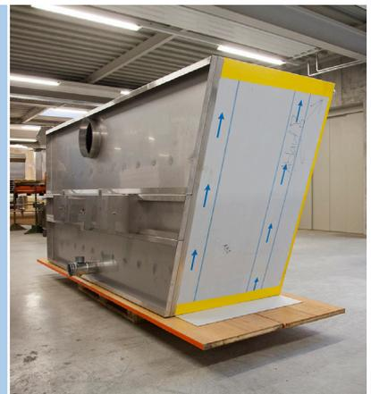
Da die Zentralen nicht auf dem Dach, sondern im fünf Meter hohen Untergeschoss platziert wurden, musste die Anlage in einzelne Module zerlegt durch eine Montageöffnung eingebracht werden. Riggenbach verfügt über langjährige Erfahrung mit solchen logistischen Herausforderungen und hat die Anlage in Zusammenarbeit mit einer darauf spezialisierten Firma planmässig positioniert.
