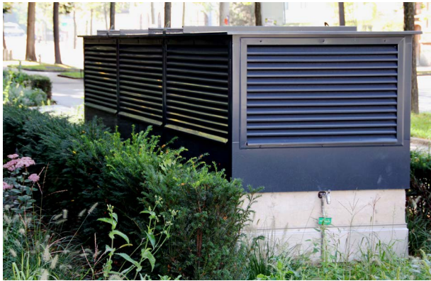
Nachströmhaube mit eingebauten Wetterschutzgittern
