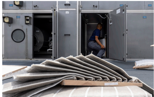
Filterwechsel: Wenn sich die Filter zersetzen, benötigt die Anlage mehr Strom. Die Mehrkosten für den Strom übersteigen schnell die Kosten für neue Filter und belasten zudem die Antriebe.
